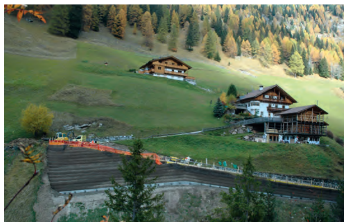
Sono in corso lavori di risanamento presso la strada "Curijel"
