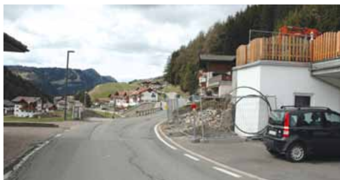
La curva piuttosto pericolosa della strada "La Poza" viene allargata.
