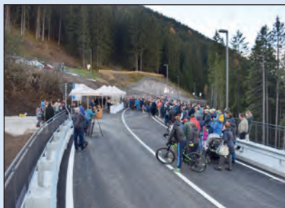
Die neue Brücke "La Sëlva"
