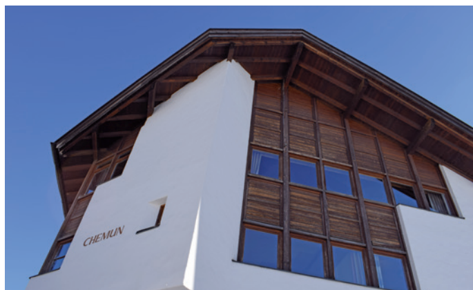
I vieresc ie n elemènt mpurtant canche l se trata de ressanamènt energetich. Nce chisc y la portes unirà giamièdes ora.
