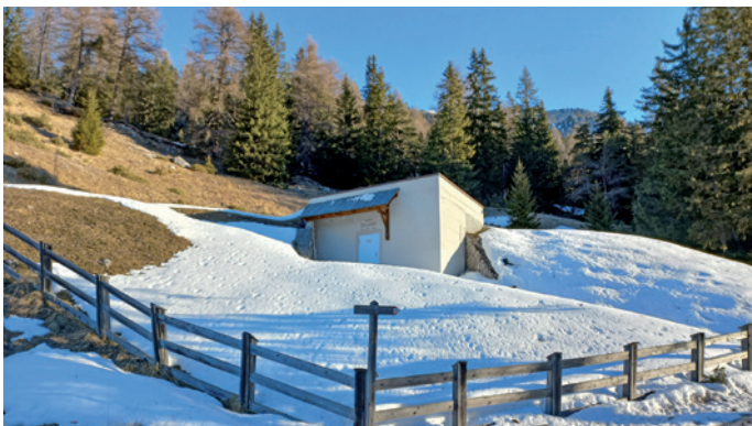
Il serbatoio per l'acqua potabile "Daunëi"
