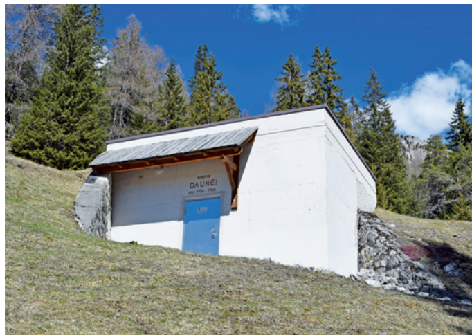
Presso i serbatoi per l'acqua potabile "Daunèi" è necessario un intervento di risanamento.
